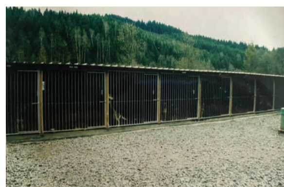
Bau von größeren Zwingeranlagen für die Zucht und Ausbildung
