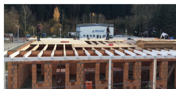
Bau des Geschäftshauses 2018
